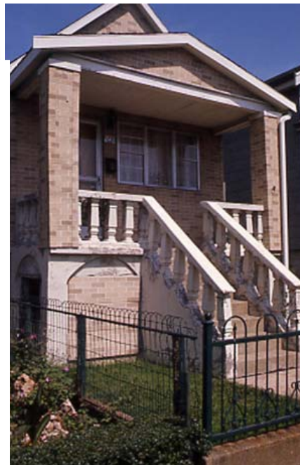
Fig. 24. Pilaster
