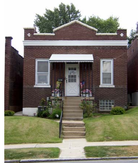
Fig. 27. Parapet
